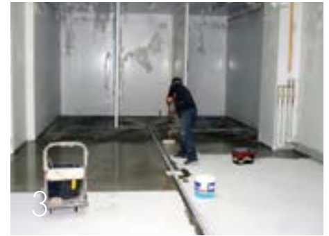
APLICACIÓN DE LA IMPRIMACIÓN
