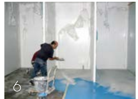
ESPOLVOREAR LA PRIMERA CAPA CON ÁRIDO DE SÍLICE
