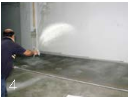
ESPOLVOREAR LA IMPRIMACIÓN CON ÁRIDO DE SÍLICE
