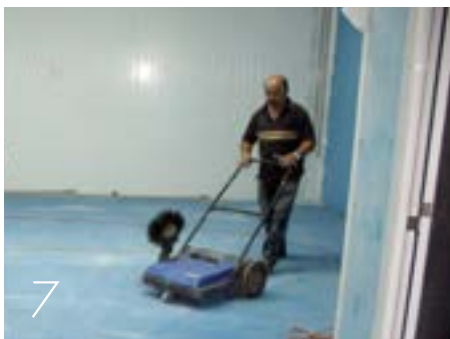
RETIRA EL EXCESO DE ÁRIDO DE SÍLICE
