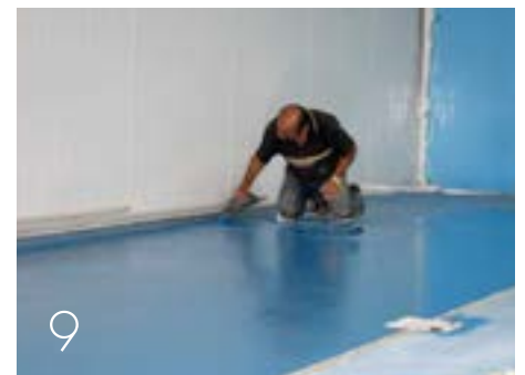
CAPA FINAL DE REVESTIMIENTO
