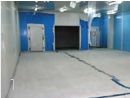
REPARACIÓN DEL HORMIGÓN
