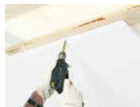
Fijación mecánica de las placas Focus F
