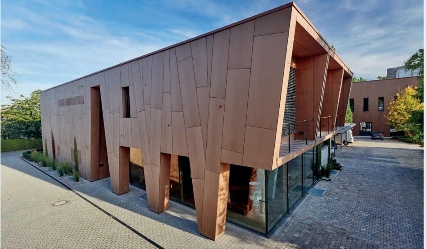
Eggenfelden, Alemania. Productos: Paneles Rockpanel | Paneles Rockclad (RAL 7016) | ROCKWOOL Fixrock
